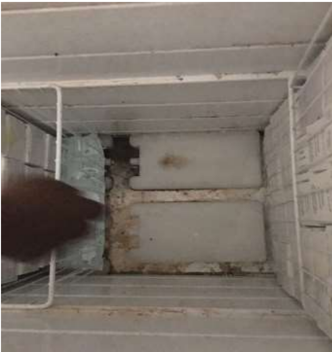
Condensation et moisissures dans le réfrigérateur du stock de vaccins ; DRAS Dakhlet Nouadhibou
