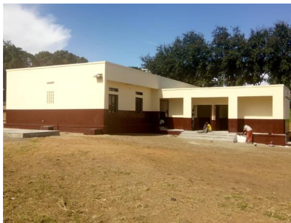
Photos : District sanitaire de Bouar, au début et à la fin des travaux
