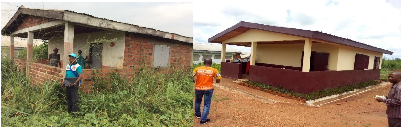
Photos : Poste de Sante de Bozere-Bali, avant et après les travaux
