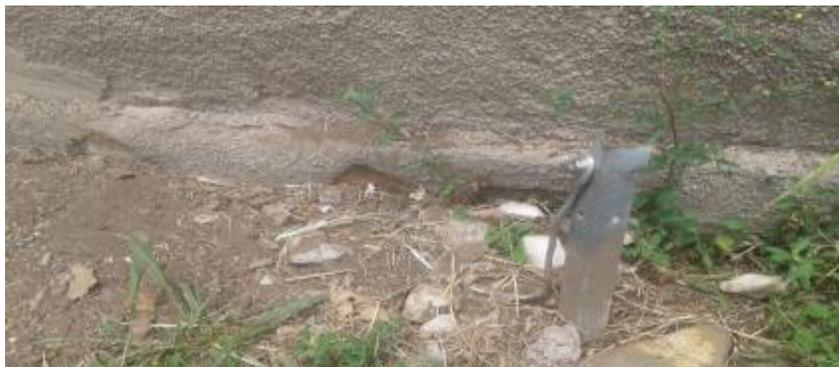
**Figure 12 : piquet de terre implanté incorrectement**
