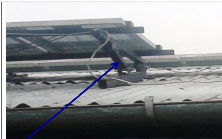
Figure 15: Au BCZ de Rwampara, c'est une structure en bois que nous avons trouvée
