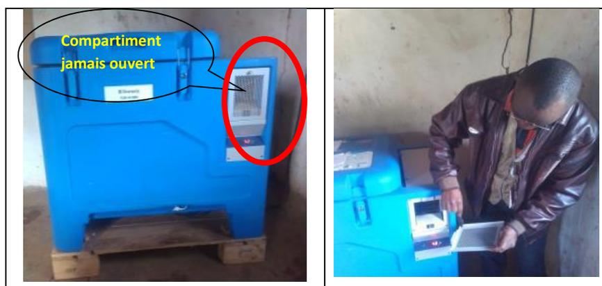
**Figure 6 : Le réfrigérateur du CS APAA/ZS Ariwara, non entretenu depuis son installation, par manque d'information**
