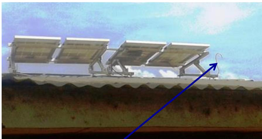
Figure 14 : Capteur installé en dessous des panneaux
