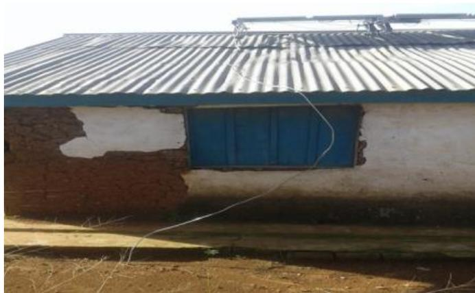
**Figure 11 : CS Saliboko/ZS Drodoro/Antenne Bunia : chemin du fil de terre curviligne**
