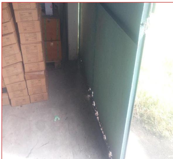
**Photo 05- DRSP Atsinanana :** Non-respect des bonnes pratiques de Stockage des consommables et des intrants (Absence de palettes et Fissures à la porte d'entrée entrainant un risque d'inondation du magasin).
